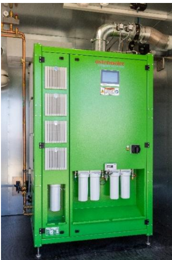
Abbildung 17: Elektrolyseanlage inklusive Brennstoffzelle
