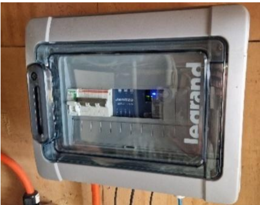
Abbildung 12: Janitza UMG103 Smartmeter im Resort (Foto: ICTnexus)
